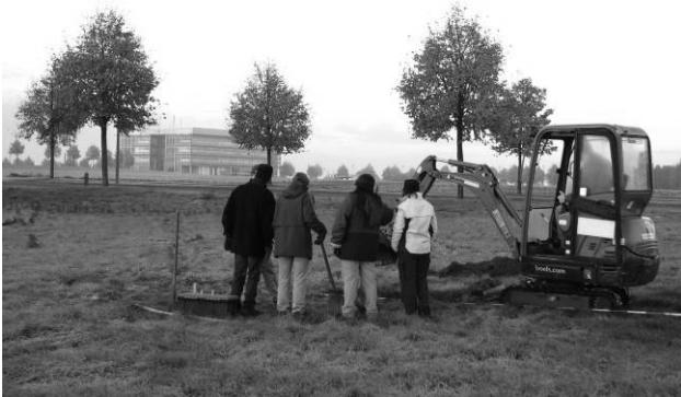
Het verwijderen van de teelaarde
