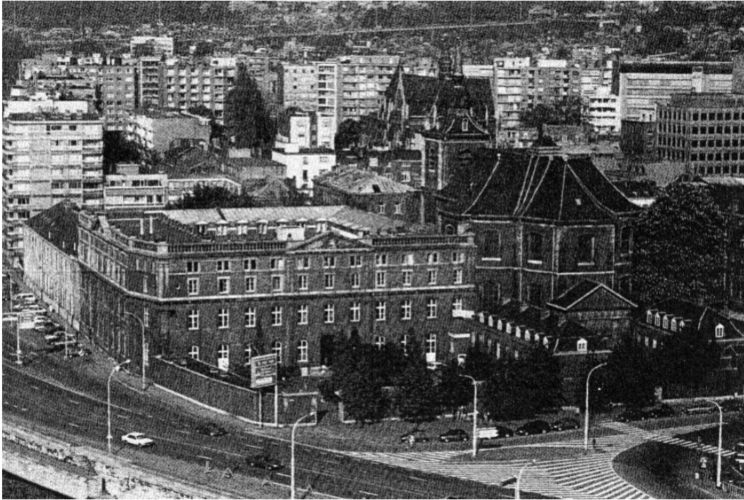
De abdij Beaurepart nu. Links onderaan het carré uit de eerste helft van de 18e eeuw, daarboven (links midden) langs de Maas oudere gebouwen van grijze natuursteen van twee verdiepingen uit de 16e en 17e eeuw, hier was o.a. de abtswoning. Deze situatie heeft pastoor Dydden meegemaakt tijdens zijn opleiding en latere bezoeken. Rechts de classicistische kerk, gewijd in 1770, op de plaats van de gotische kerk die in 1554 geconsacreerd is en die in het gedenkboek van de parochie door Luc Wolters op p. 21 is afgebeeld. Pastoor Sougnez heeft de afgebeelde situatie meegemaakt, maar het carrégebouw telde toen maar twee verdiepingen.
