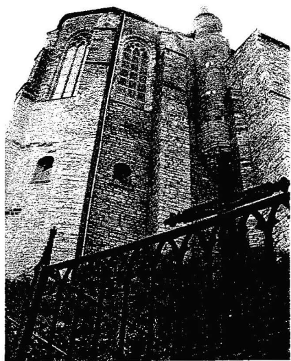
De kerk die over de afgrond heen naar het oosten is uitgebreid.
